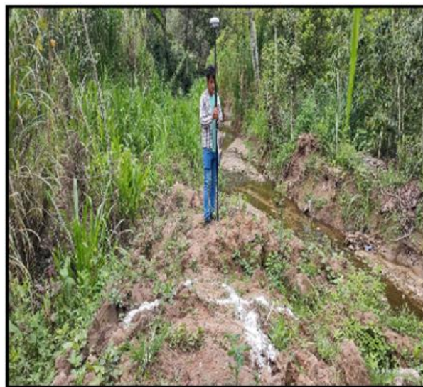
FIGURA N°02: TRAMO CRÍTICO EN LA QUEBRADA, CON BORDES EROSIONADOS, EN TIEMPOS DE AVENIDAS SE DESBORDA GENERANDO INUNDACION.
